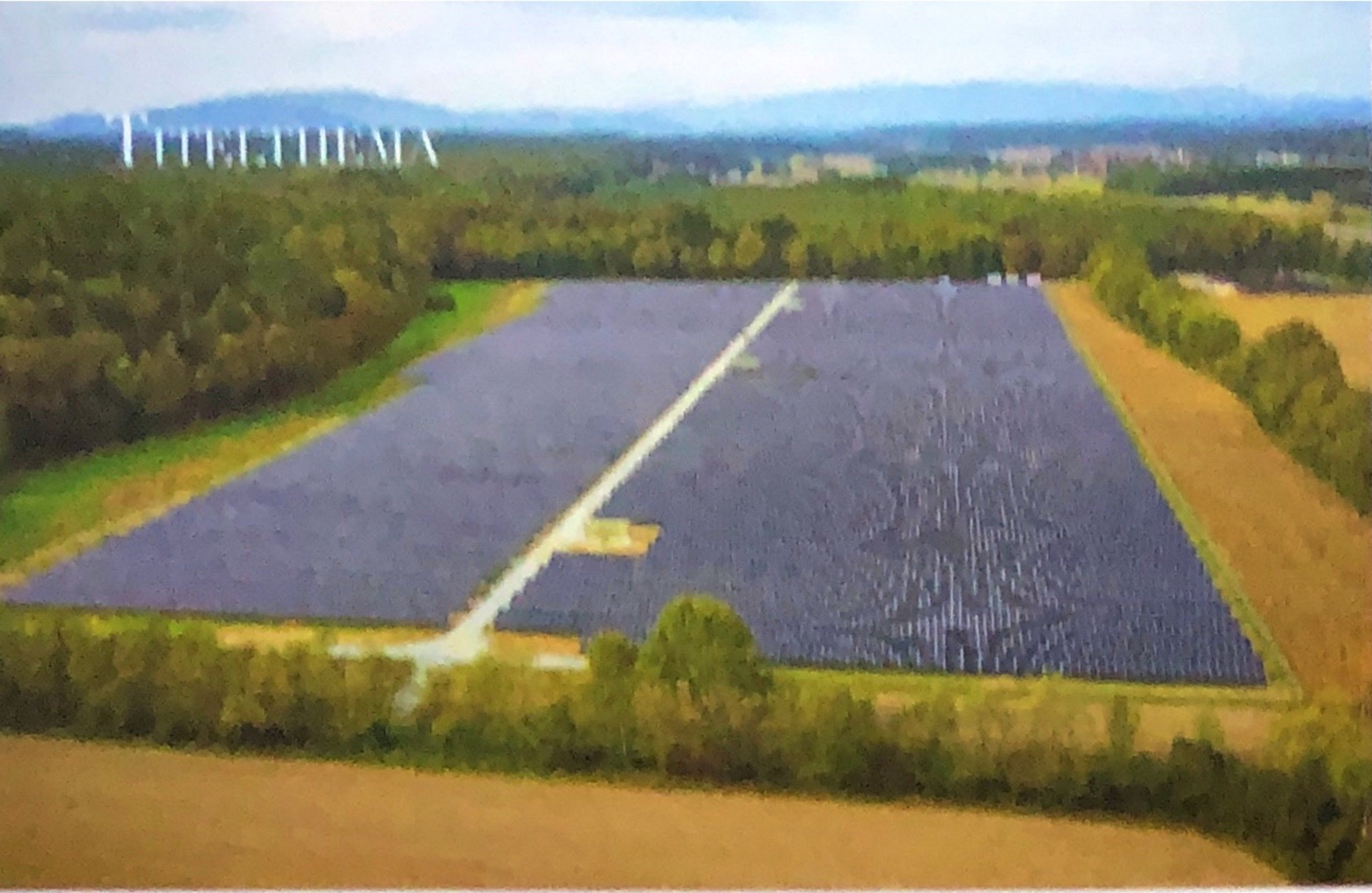
Die Fotovoltaikanlage in Neudau erzeugt Strom für 3500 Haushalte
